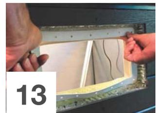
Coller le joint intérieur de la buse de refoulement et du projecteur. (Photo 14-15-16)
